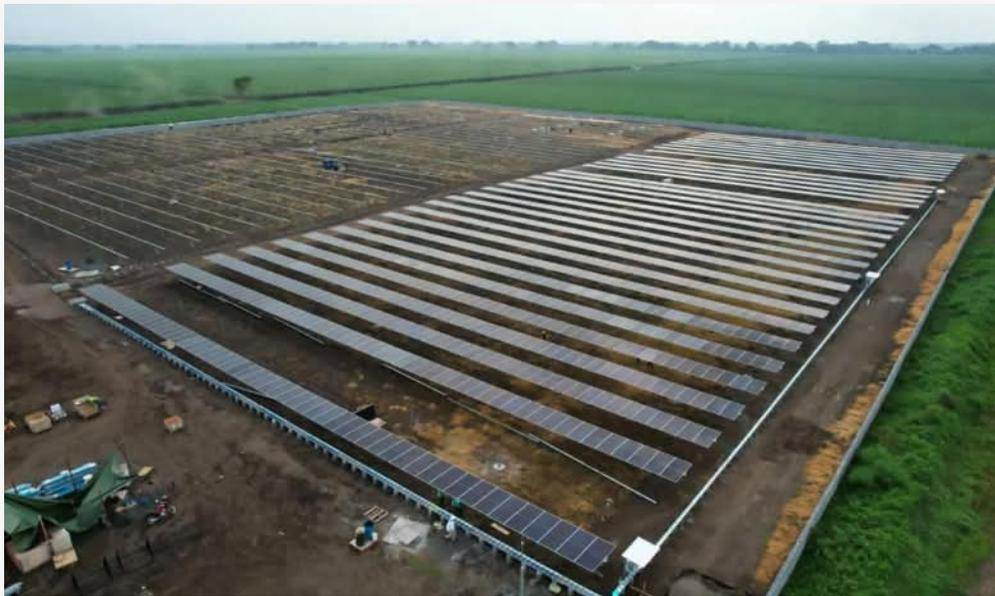
En el 2024 Enerxia se adjudicó un proyecto para la construcción de una planta solar en La Gomera, Escuintla. Este es un proyecto de 3.72MWp, con entrega de 2.5MW a la red de la Empresa Eléctrica de Guatemala (EEGSA) a construirse en el 2025 con tecnología de clase mundial.
