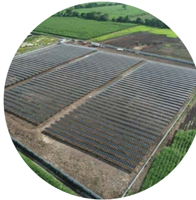
Parque Solar La Gomera
